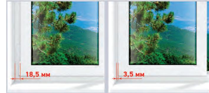
За счет механических свойств скрытых петель при открывании окна створка смещается к центру. Благодаря чему значительно упрощаются требования к расположению откосов при монтаже. Потому со скрытыми петлями разрешается больший нахлест откоса на раму.
